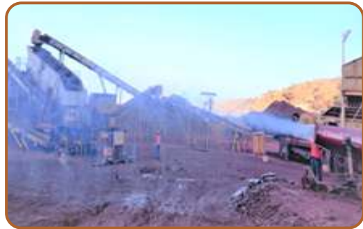
Fogger type Dust Suppressor
